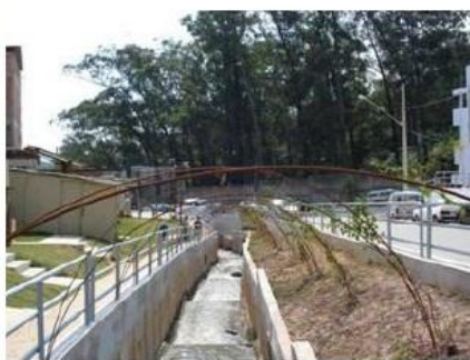
urbanização em andamento
