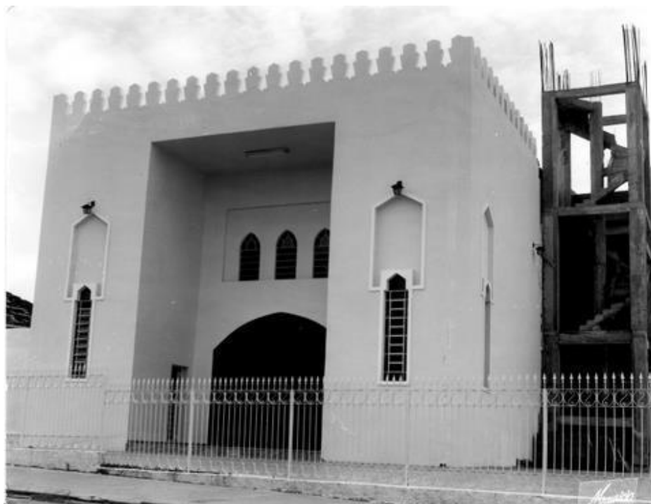
Figura 10 - Mesquita ainda em construção, sem a edificação completa do minarete. Nesse período, o espaço interno já era utilizado para prática religiosa e social entre a comunidade muçulmana na cidade.
