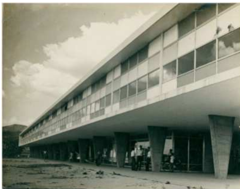
Fotografia 3 - Colégio Estadual Central em Belo Horizonte
