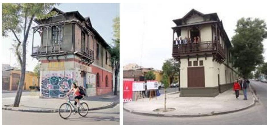
Figura 5. Antes e depois da reabilitação do edifício Abate Molina
