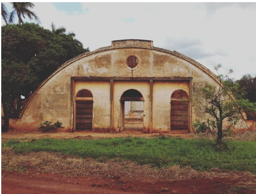
Figura 3: Estrutura onde funcionava o cinema da Fazenda Palmeiras
