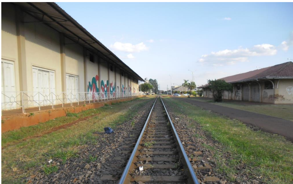
Figura 5: Estação e barracão da ferrovia em Arapongas. Fonte: Os autores (2018).
