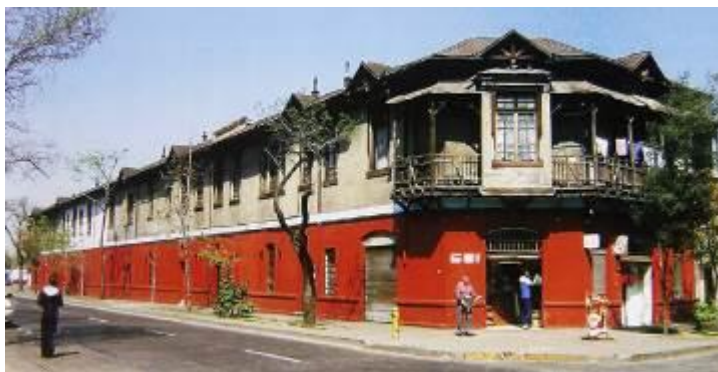
Figura 4: Edifício Abate Molina em situação de deterioro.
