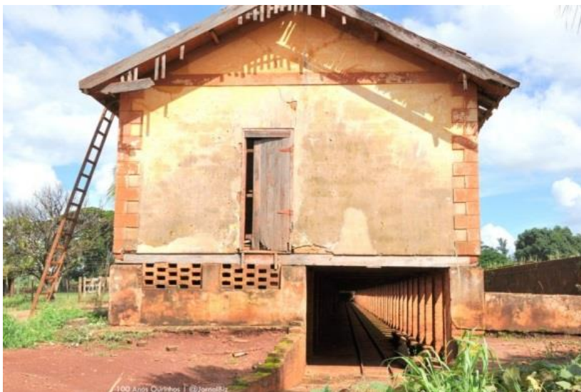
Figura 2: Túnel para vagonetes na Fazenda Palmeiras
