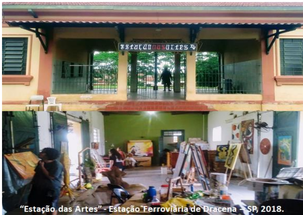
Figura 01: Estação ferroviária de Dracena – SP. Fotos do autor, 2018
