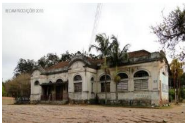
Figura 6 Primeira Estação de Avaré - situação atual
