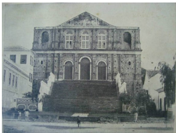
Figura 01: Final do século XIX, situação da Igreja ainda sem as torres e sem a fachada atual.
