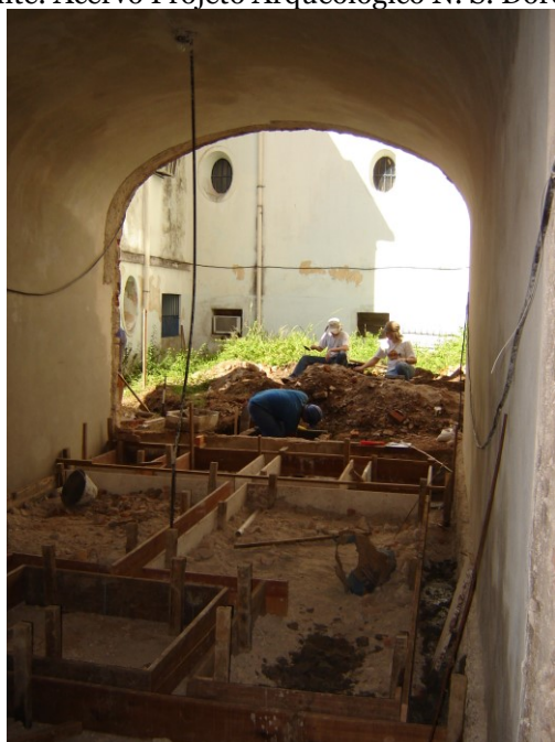
Figura 06: Construção dos banheiros sob a abóboda. Ao fundo, acompanhamento da abertura da rede de esgoto no setor 2C. Fonte: Acervo Projeto Arqueológico N. S. Dores.
