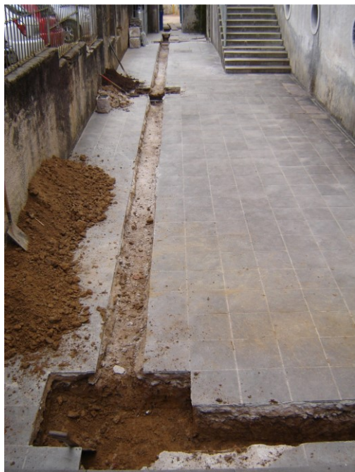
Figura 04: Setor 1, Lateral Oeste. Instalação da rede de esgoto. Sentido sul-norte. Fonte: Acervo Projeto Arqueológico N. S. Dores.
