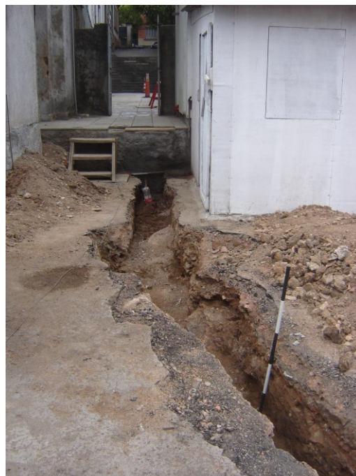
Figura 05: Setor 1, Lateral Oeste. Prolongamento da rede de esgoto. Sentido norte-sul. Fonte: Acervo Projeto Arqueológico N. S. Dores.
